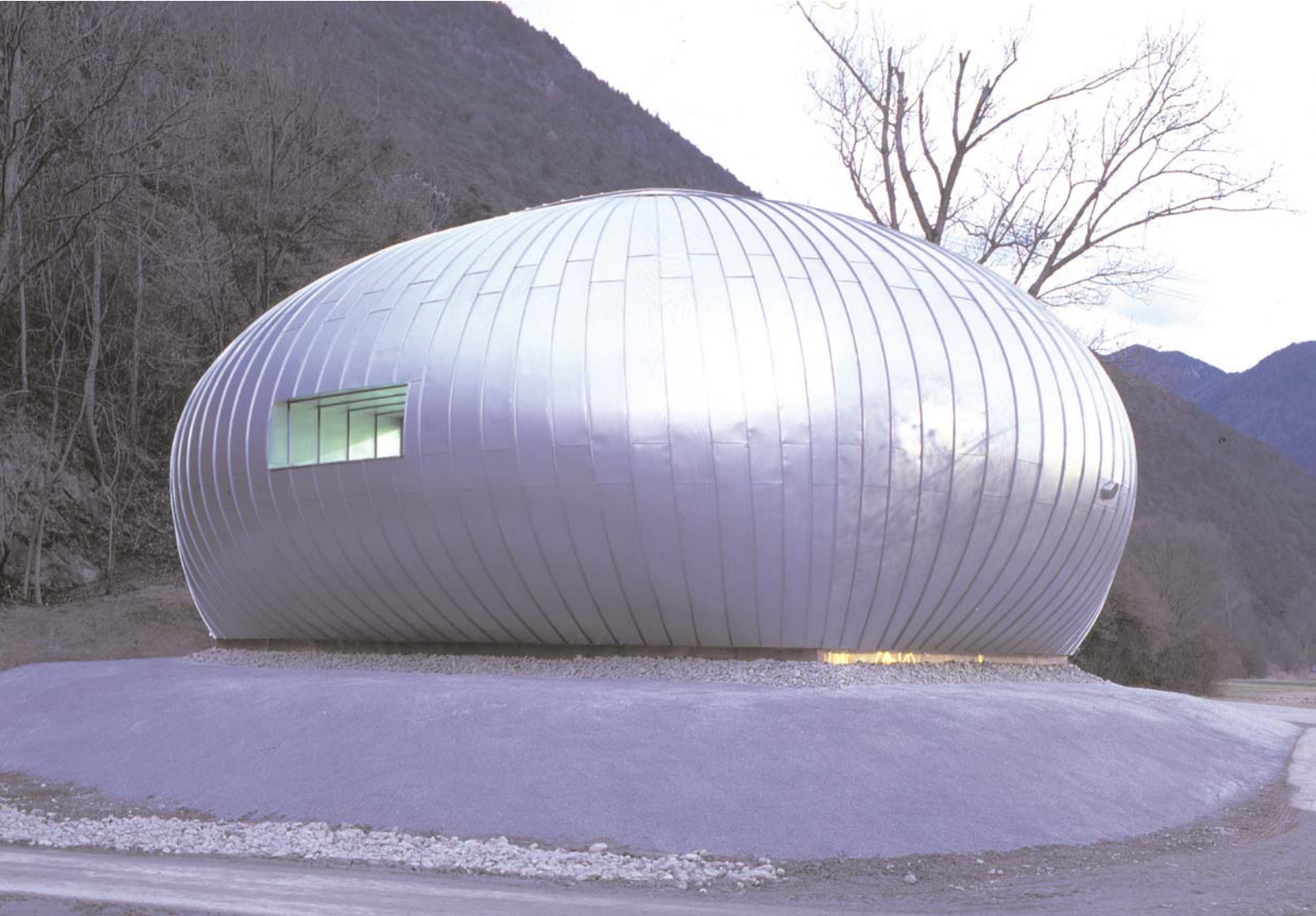
Im Krafthaus der Abwasserentsorgung Seefeld in Tirol wird aus Abwasser Energie gewonnen.
