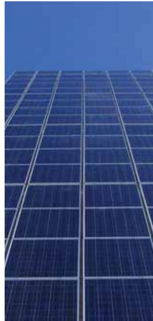
Umwelttechnik mit doppeltem Nutzen: Siemens hat die Fassade der Abfallverwertungsanlage in Trezzo in der Lombardei mit Solarmodulen verkleidet und die Anlage ans örtliche Stromversorgungsnetz angebunden.
